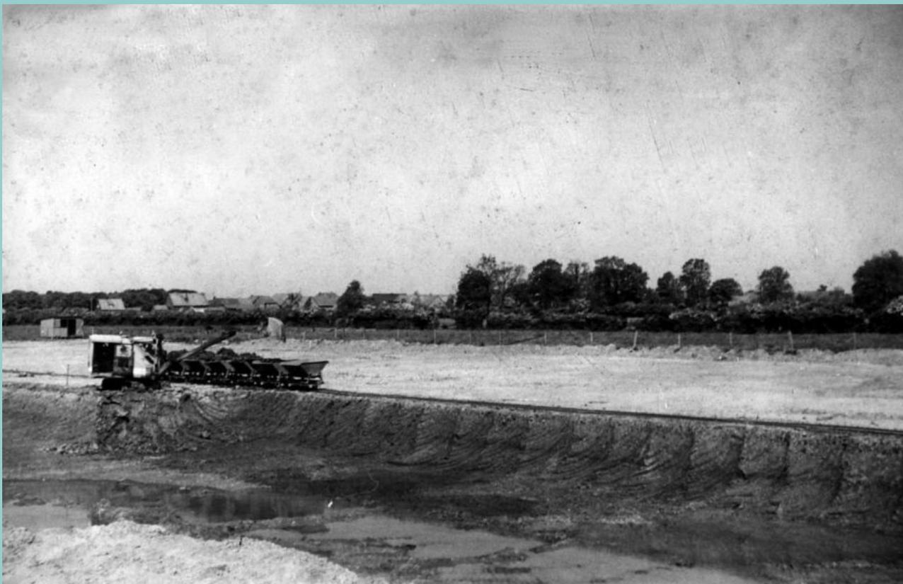
Der Grundstoff für die Ziegelproduktion war der Ton. In der Wellier Marsch lag der Ton ca. 40 cm unter der Erdoberfläche und war ein bis zwei Meter mächtig.
